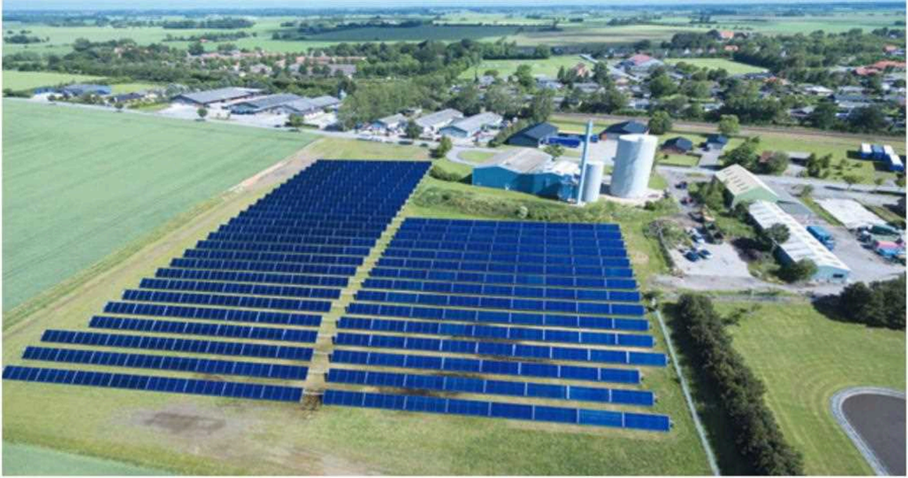
丹麦 Søllested 的太阳能区域供热厂由 4,700 平方米的双层玻璃平板集热器组成 照片SavoSolar / 欧洲太阳能供热公司
