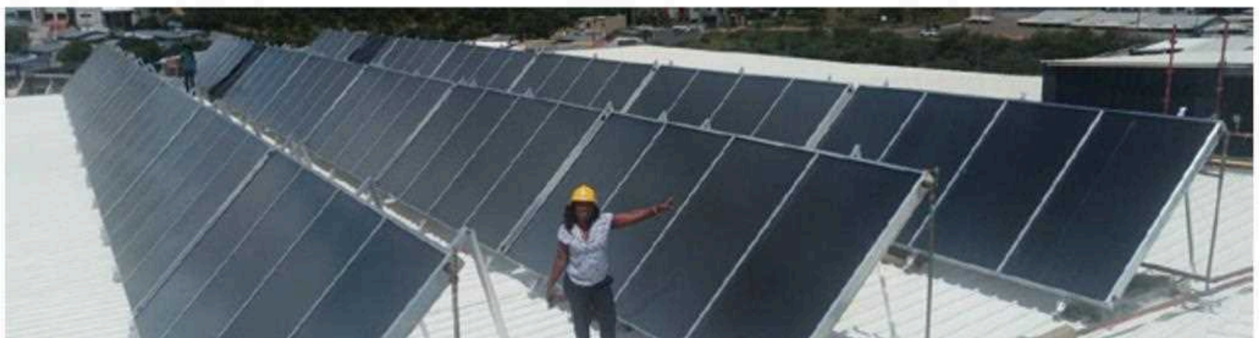
纳米比亚温得和克波汉巴夫人医院的 210 平方米抽水平板集热系统 照片维尔纳-魏斯, AEE INTEC
