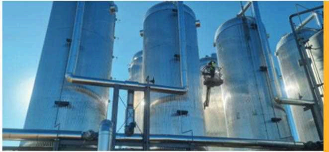
西班牙塞维利亚喜力啤酒厂的蓄热器 照片西班牙 Engie 公司
