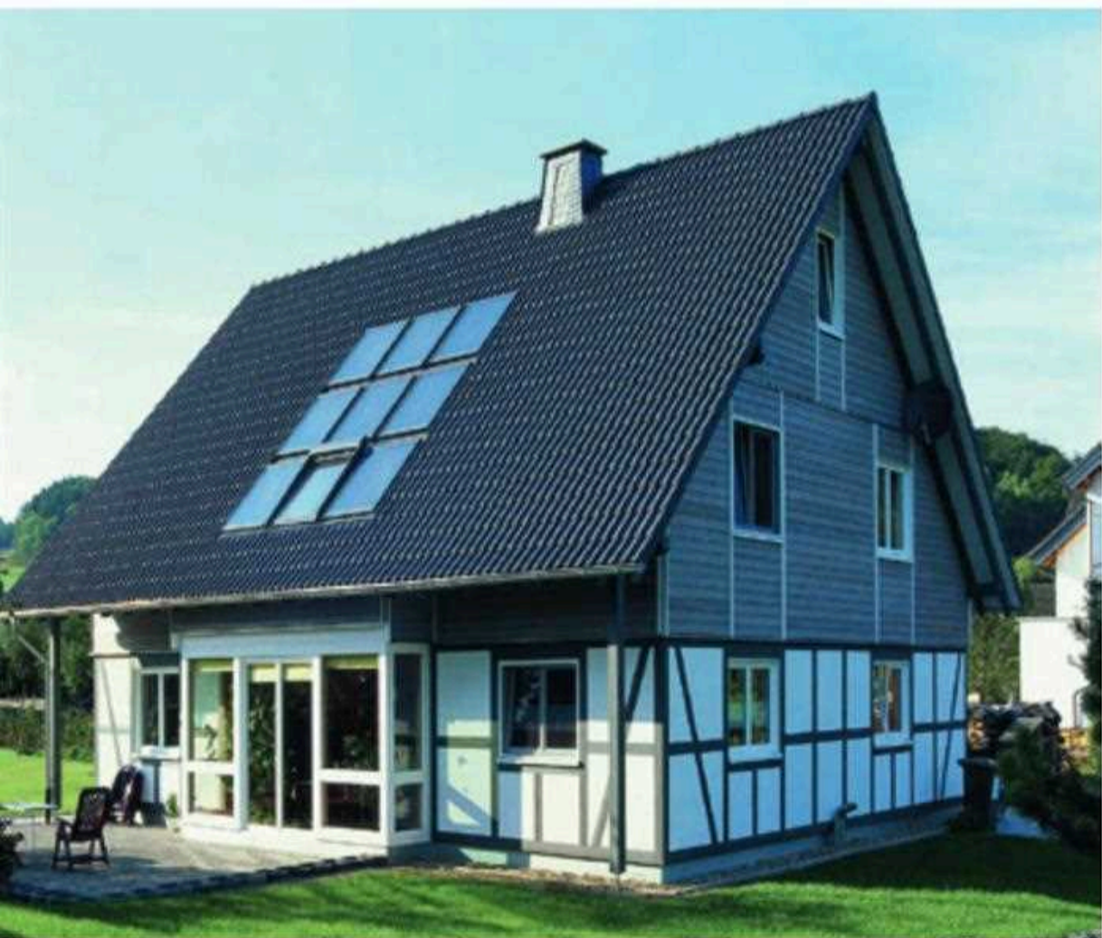
用于制备热水的屋顶一体化太阳能系统 照片 Velux / 欧洲太阳能供热公司
