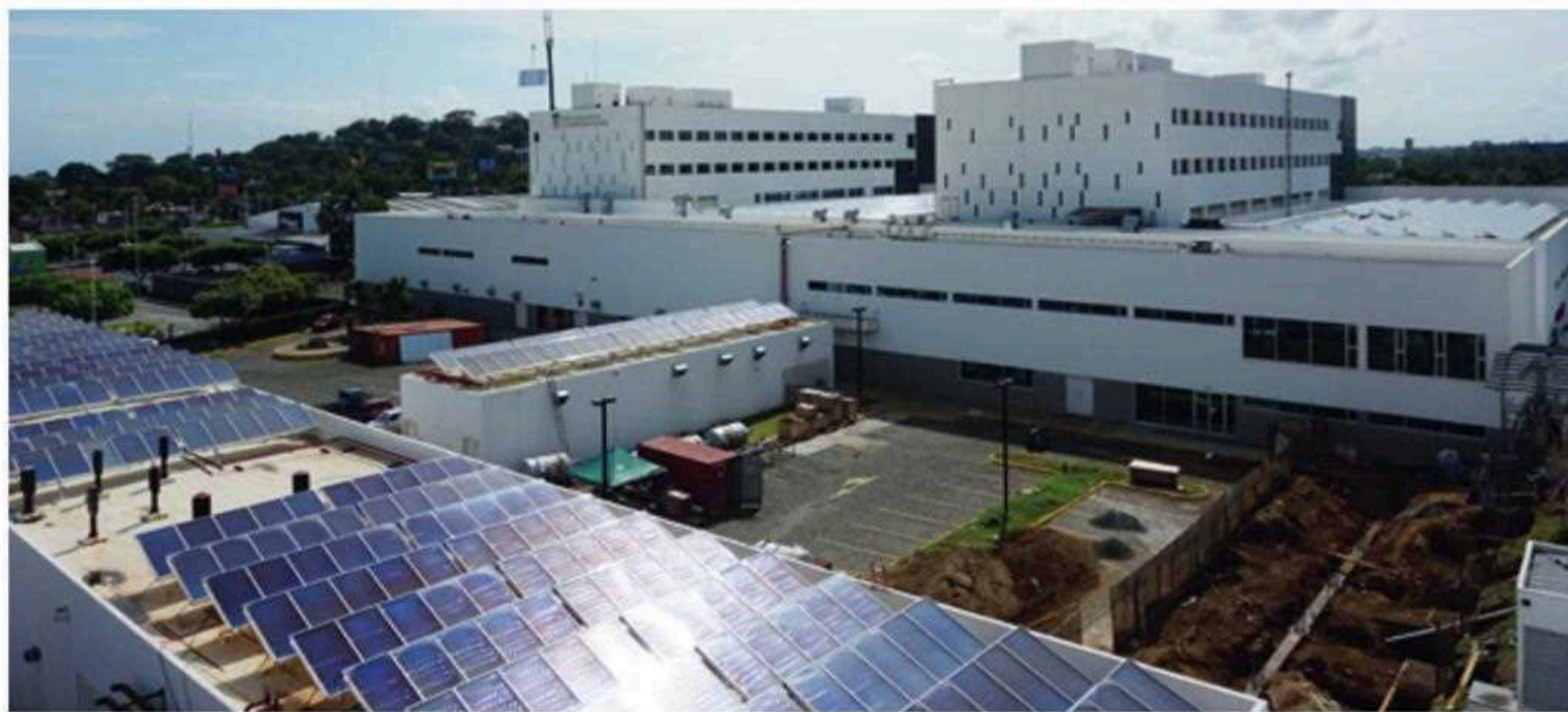
尼加拉瓜马那瓜军事学校医院 1 兆瓦太阳能冷却系统 照片：SOLID 太阳能系统
