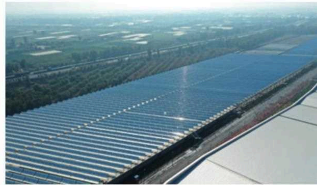
中国邯郸湾水世界的 80 兆瓦抛物面槽式集热系统为室内滑雪馆供雪、供热和制冷 照片: 内蒙古旭宸能源有限公司
