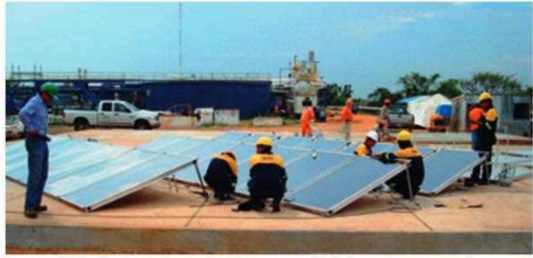
墨西哥的平板集电系统 照片 Mexichem / Solar Payback
