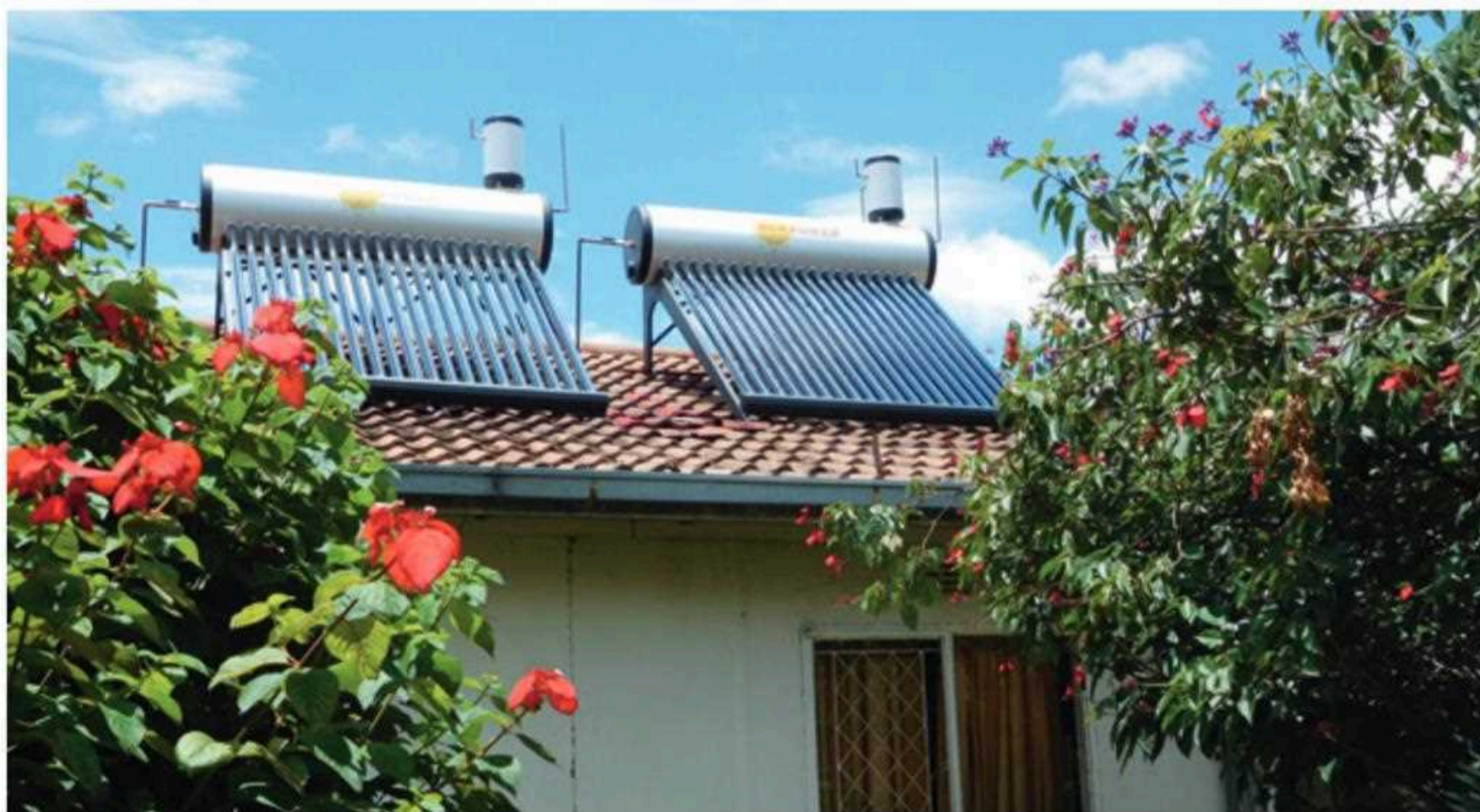
津巴布韦哈拉雷 CPS 姐妹青年旅舍的热虹吸系统 照片维尔纳·魏斯, AEE INTEC
