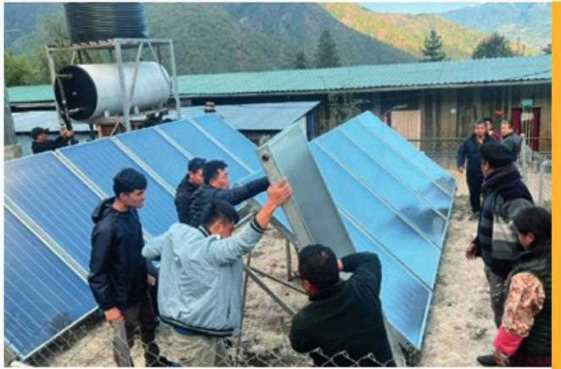
在不丹安装地面太阳能热水系统
