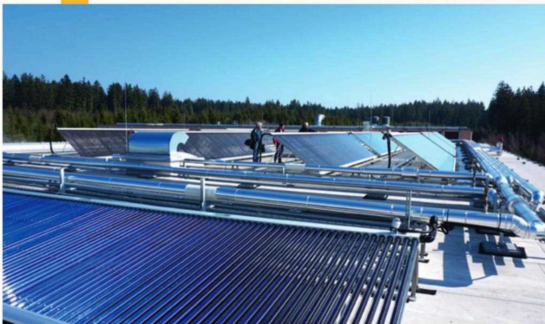
在德国的 Rothaus 啤酒厂，近 1,000 平方米的真空管集热器为洗瓶机提供热量 照片德国 Rothaus 啤酒厂
