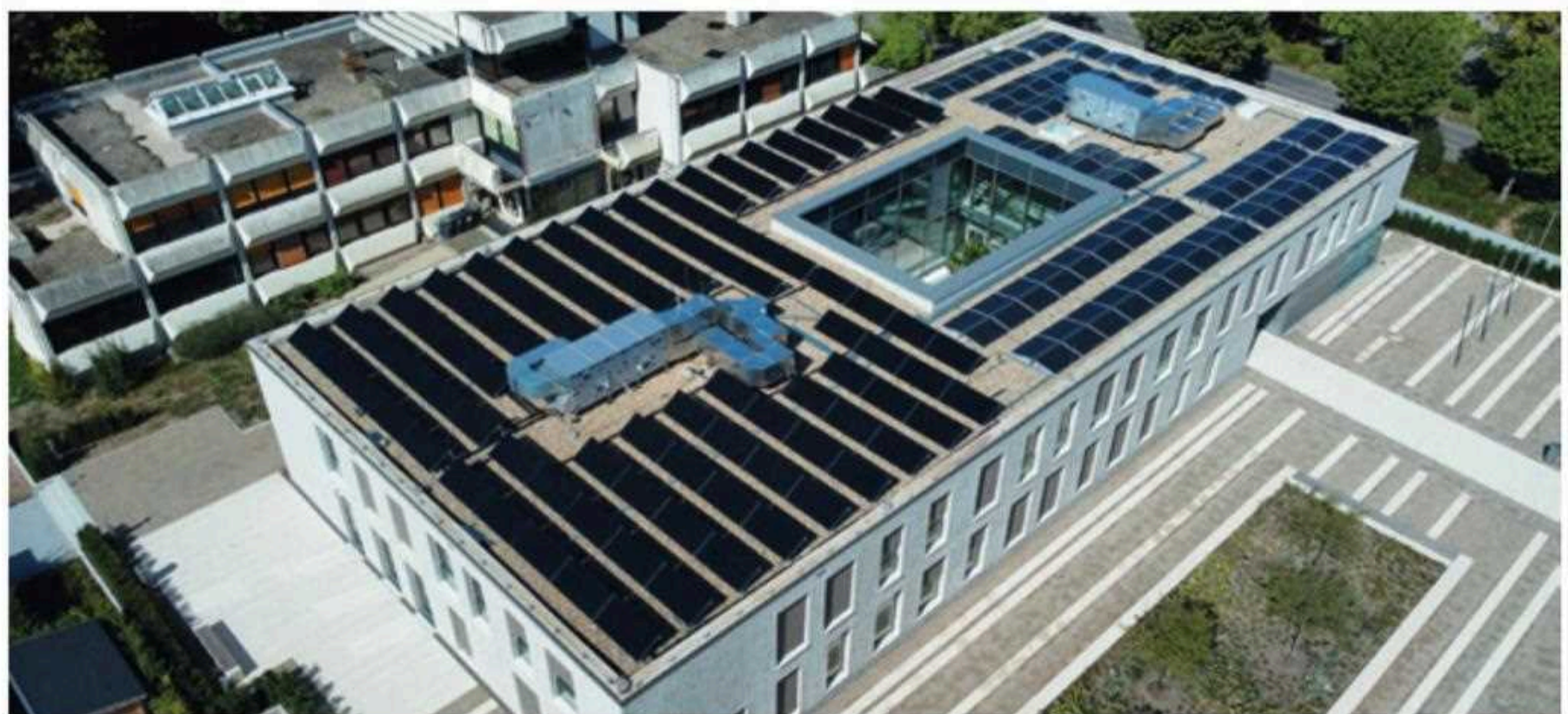
德国 Offenbach an der Queich 市政厅的 100 块 PVT 太阳能电池板与 50 千瓦热泵结合使用
